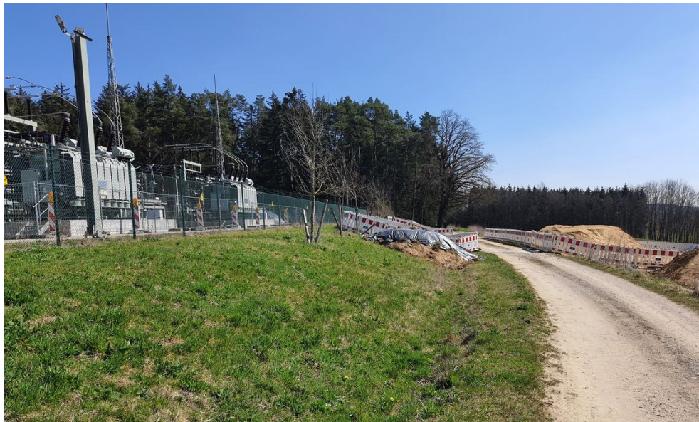
Foto 3: Blick nach Osten, vorhandenes Um- spannwerk
