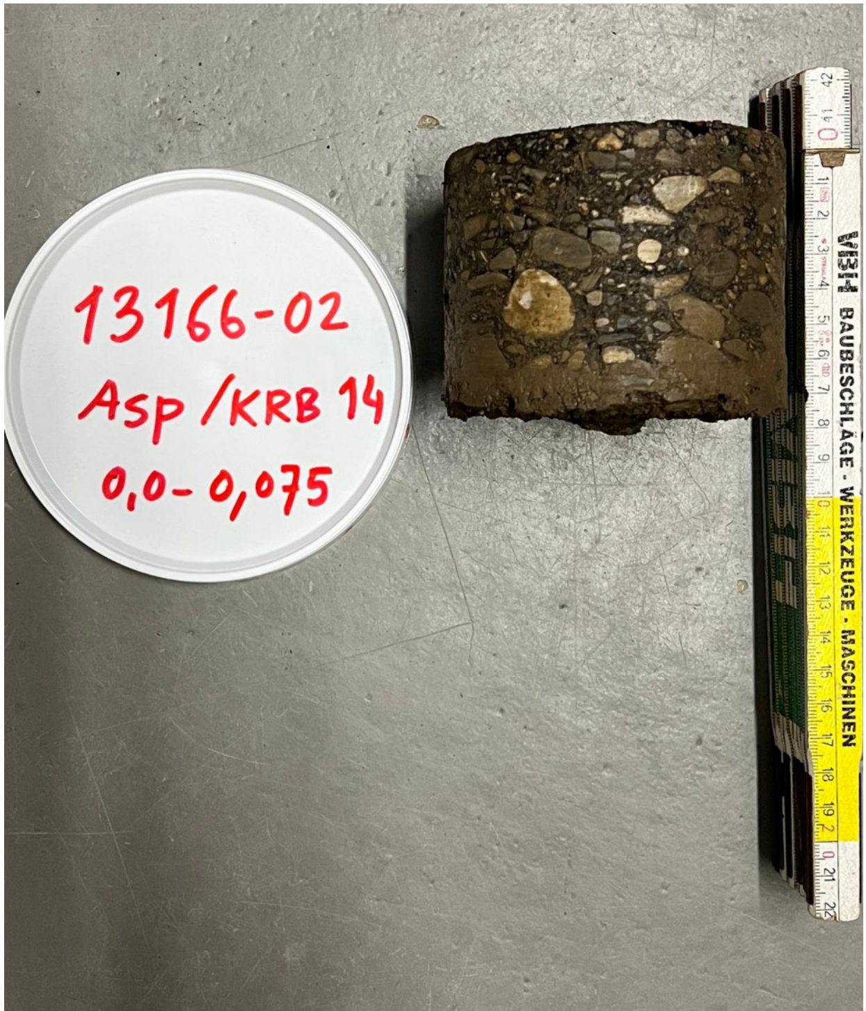
Abb. 1, 07.11.2024: Asphaltbohrkern bei KRB 14 (Asp 14), Asphaltdeckschicht: 7,5 cm
