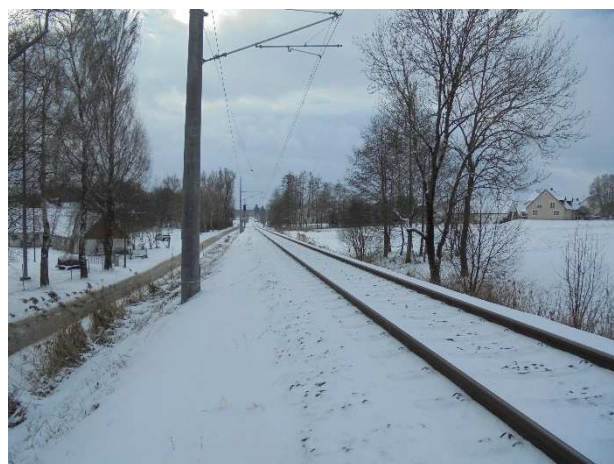
Bild 14: Bahnlinie Richtung Dachau (S)
