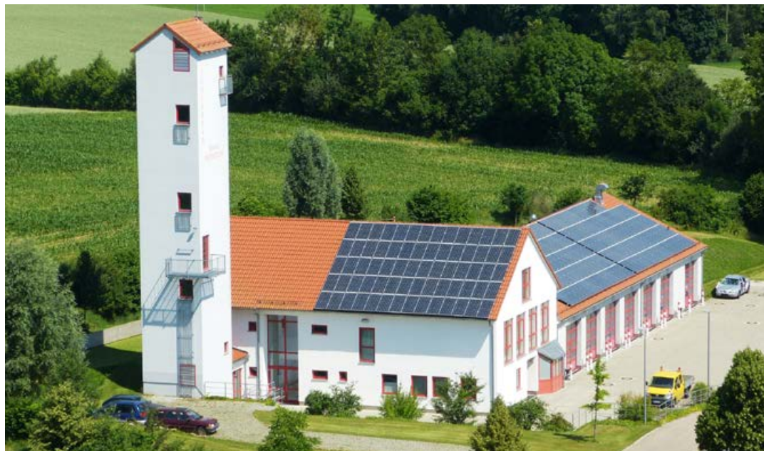
Feuerwehrgerätehaus Markt Indersdorf
