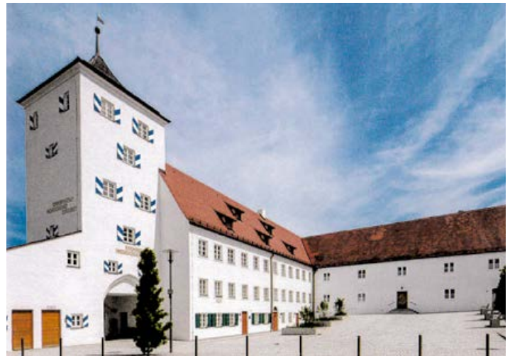
Schneiderturm mit Mesnerhaus
