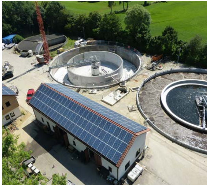
Kläranlage Markt Indersdorf
